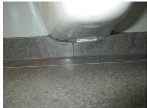
Ingen åpning for synliggjøring av lekkasjevann
