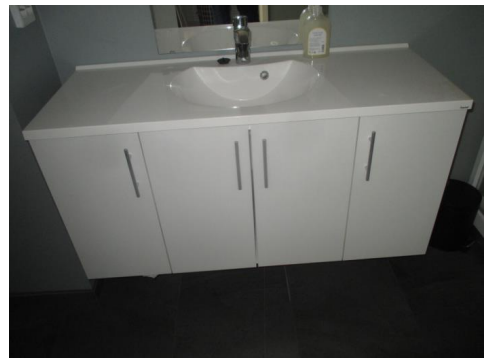
Ingen åpning for synliggjøring av lekkasjevann
