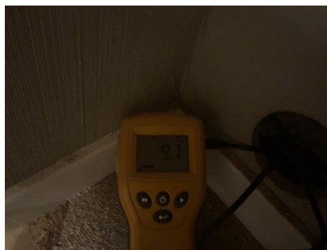
Tørt i vegg ved trapp
