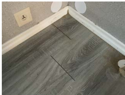
Fukt i vegg ved bad leilighet
