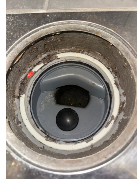
Sluk i plast, plassert i dusjnisje
