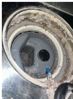
Plastsluk med klemring for membran
