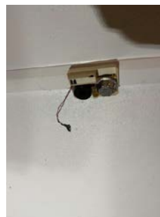
Flere av brannvarslere er frakoblet.
