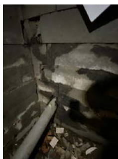
Avløp ut til grunn fra krypkjeller.
