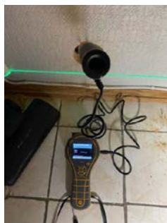
Fuktmåling med pigger i tre mot våtsonen.
