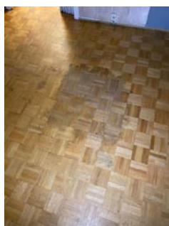
Slitasje/oveflateskader i gulv, 1. Etg.
