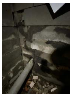
Avløp ut til grunn fra krypkjeller.
