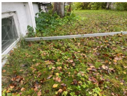
Fall på terrenget mot mur.
