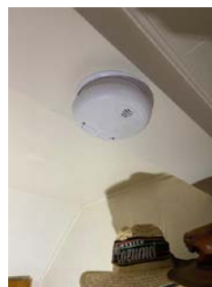
Flere av brannvarslere er frakoblet.
