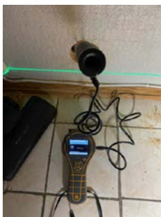
Fuktmåling med pigger i tre mot våtsonen.
