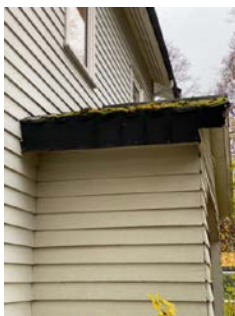
Takoverbygg over inngangsparti.
