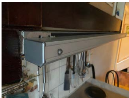
Skjevheter på uttrekk.
