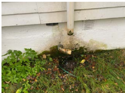
Nedløpsrør mot nord.
