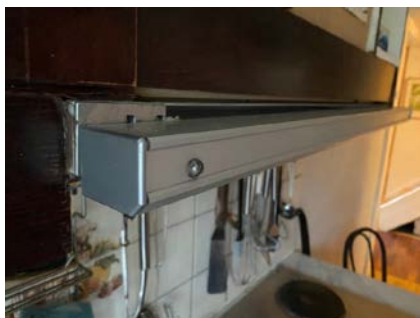
Skjevheter på uttrekk.
