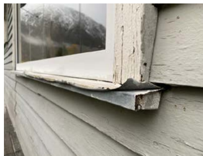
-Utvendige omrammingsbord på vinduer er stedvis satt helt ned på beslag, skadeutsatt løsning med fuktopptrekk og påfølgende råteskader.
