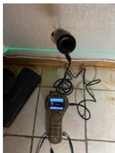
Fuktmåling med pigger i tre mot våtsonen.
