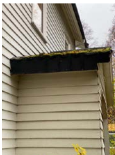
Takoverbygg over inngangsparti.
