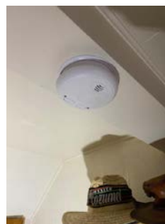
Flere av brannvarslere er frakoblet.
