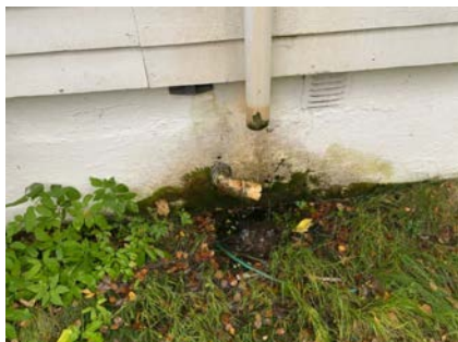
Nedløpsrør mot nord.
