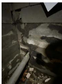
Avløp ut til grunn fra krypkjeller.
