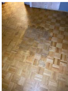
Slitasje/oveflateskader i gulv, 1. Etg.
