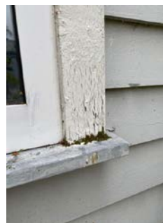
-Utvendige omrammingsbord på vinduer er stedvis satt helt ned på beslag, skadeutsatt løsning med fuktopptrekk og påfølgende råteskader.
