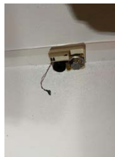
Flere av brannvarslere er frakoblet.
