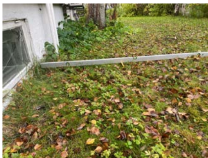
Fall på terrenget mot mur.
