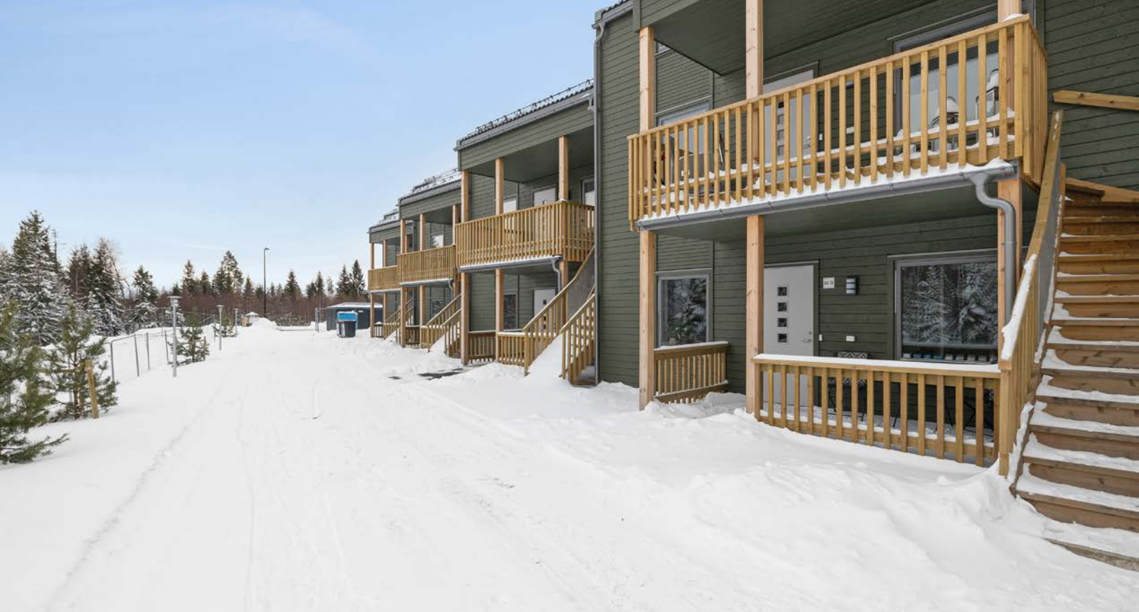
Fasade. Sameiets tomt blir/er opparbeidet med internveier og plenarealer.
