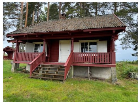
Tretakrenne kun på deler av front med "nedløp" av kjetting
