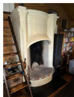
En side av pipevange dekket med tømmervegg
