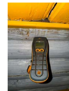
Forhøyede fuktverdier og fuktmerker på innvendige stokker på soverom i 2.etg.
