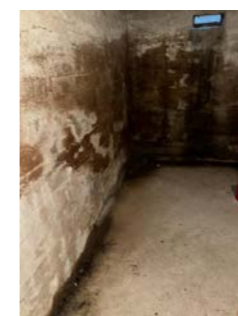
Synlig fuktvandring i gulv og vegger i kjeller
