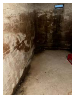
Betongdekke i kjeller under kjøkken/soverom
