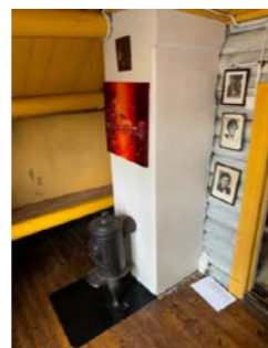
En side av pipevange dekket med tømmervegg
