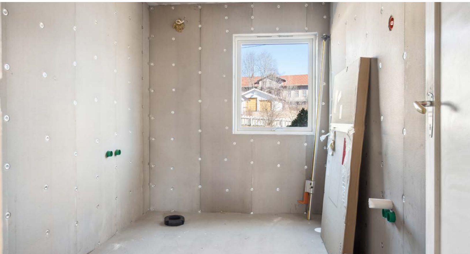
I 1. etasje er det et bad som er under bygging. Det er bla. støpt gulv m/varmekabler og det meste av rør og el. anlegg er ferdigstilt.
