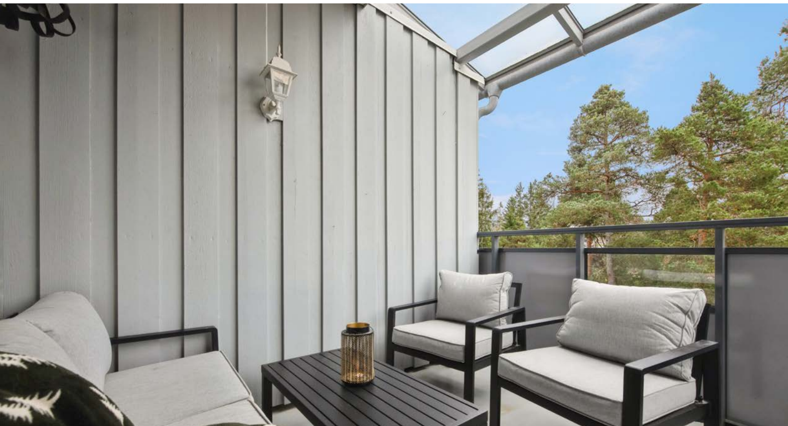
Overbygget balkong med nyere rekkverk og glasstak.
