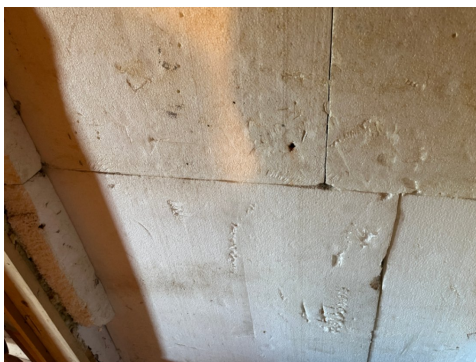
Vegger i kryprom
