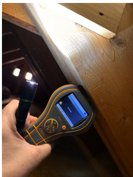
Ingen utslag på fuktighet i sperre
