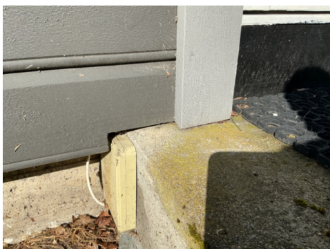
Liten avstand til betong
