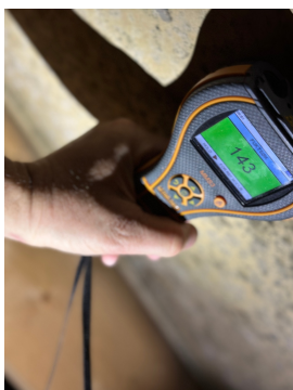
Ingen fuktighet under muggsopp
