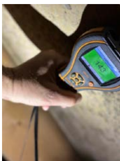
Ingen fuktighet under muggsopp
