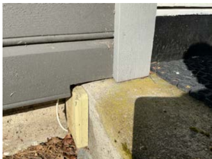
Liten avstand til betong
