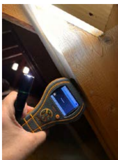
Ingen utslag på fuktighet i sperre
