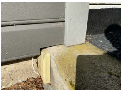
Liten avstand til betong
