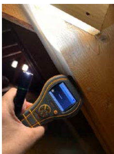
Ingen utslag på fuktighet i sperre
