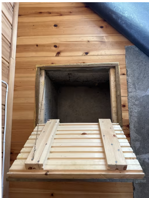
Viser luke i gulv på kjøkken.
