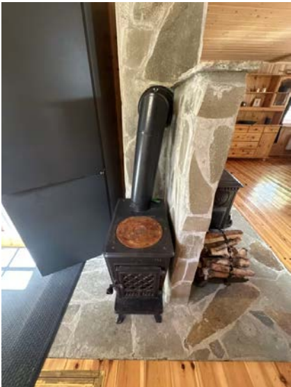
Viser vedovn monter ved kjøkken. Noe nært kjøleskap.
