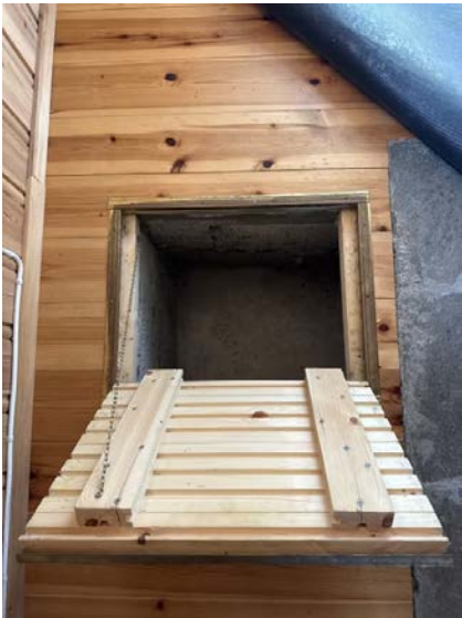
Viser luke i gulv på kjøkken.
