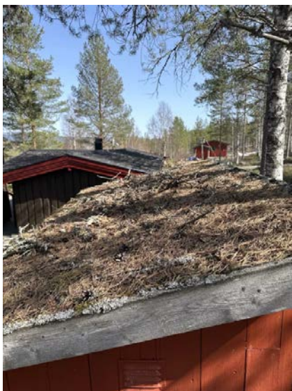
Pulttak med tekking av papp/mose.
