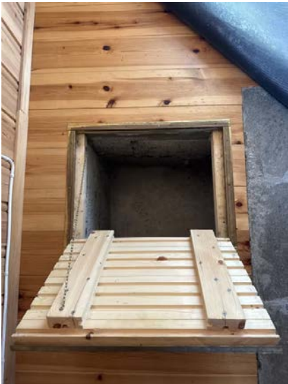
Viser luke i gulv på kjøkken.
