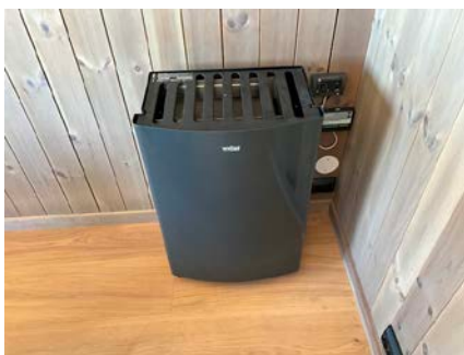
Dieselvarmer (ring hytta varm)
