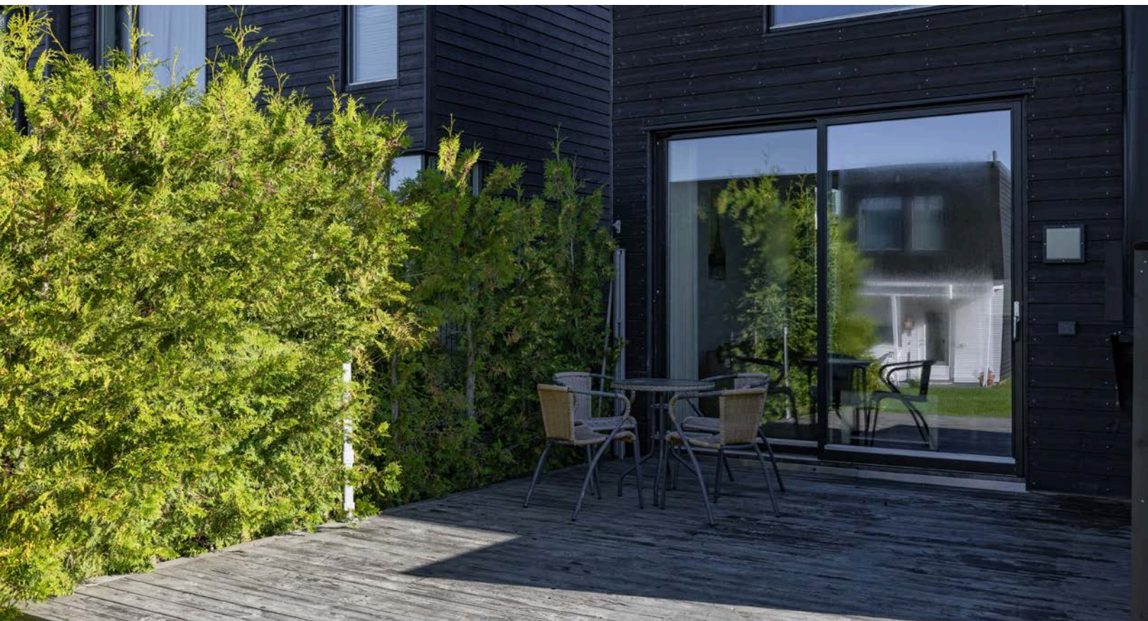
Terrassen har terrassebord på gulv, levegg mot nabo og stor hekk i andre enden. Det er god plass til sittegruppe etter eget ønske, samt utebelysning og stikkontakt på vegg.
