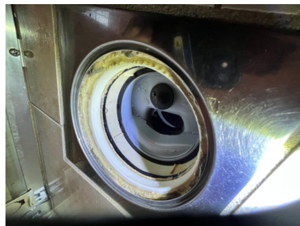
Sluk med synlig mansjett
