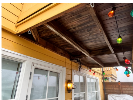
Altan festet på utside av bordkledningen
