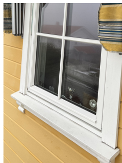
Slitasje/skade på overflate behandlingen
