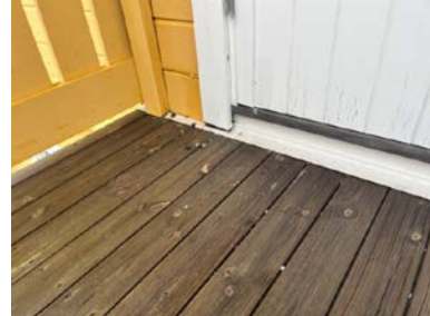
Bordkledning helt ned mot gulv
