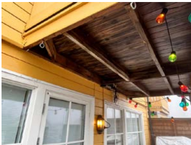
Altan festet på utside av bordkledningen
