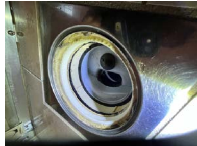
Sluk med synlig mansjett
