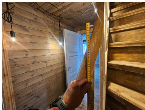
Rekkverk er målt til over 90cm.
