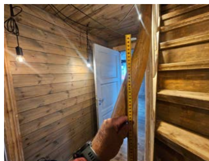
Rekkverk er målt til over 90cm.
