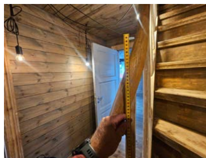
Rekkverk er målt til over 90cm.
