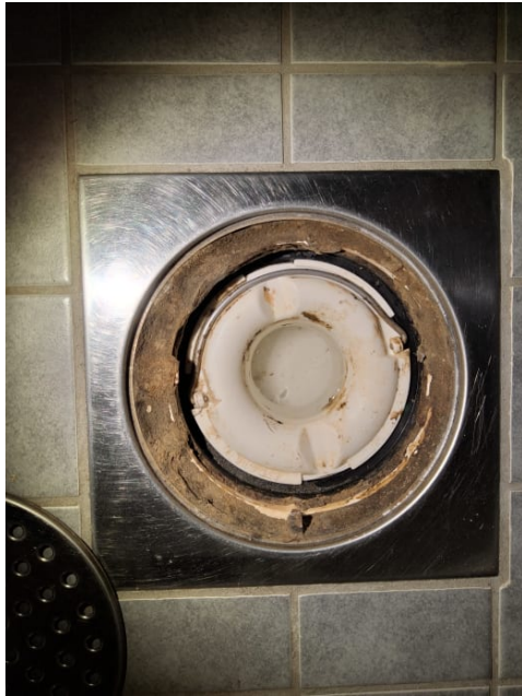
Sluket klemring er dekket av flislim.
