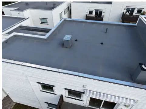
Taktekking av PVC-basert takmembran.
