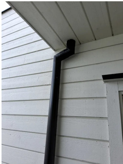
Nedløpsrør av metall tilknyttet takoverbyggd inngangsparti.
