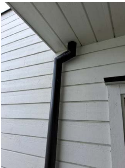
Nedløpsrør av metall tilknyttet takoverbygd inngangsparti.
