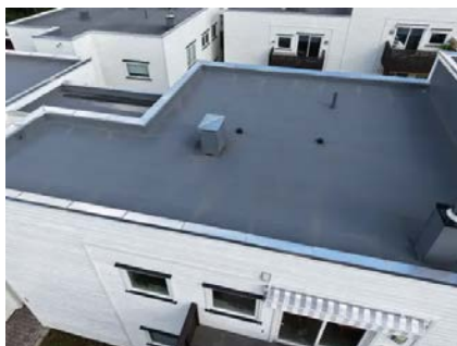
Taktekking av PVC-basert takmembran.
