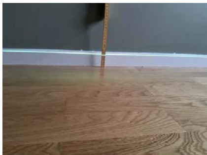
Etasjeskillet er kontrollert med nivelleringslaser.
