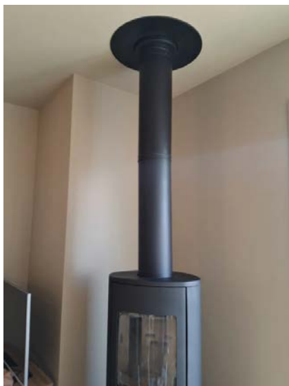
Vedovn med stålpipe i stue.
