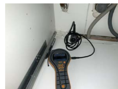
Fuktmåling i svill fra kjøkken.
