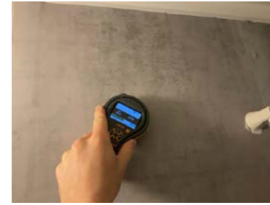
Ved bruk av fuktindikator på utsatte steder registrerte jeg ingen unormale verdier.
