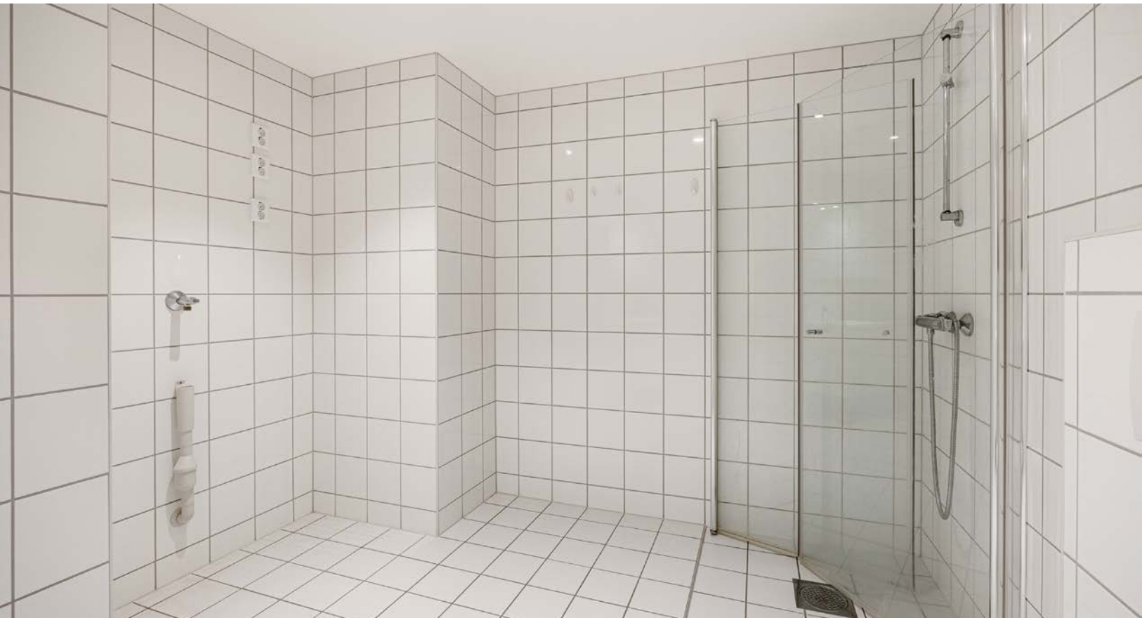
Varme er lagt i gulvet, toalettet er vegghengt og dusjhjørnet har innfellbare dører i herdet glass. Videre er det opplegg for vaskemaskin og tørketrommel.
