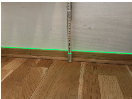
Etasjeskillet er kontrollert med nivelleringslasere.
