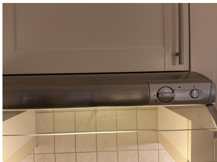
Mekanisk avtrekkseffekt reguleres fra kjøkkenventilator.
