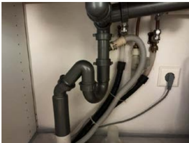
Leiligheten har synlige avløpsrør i plast.
