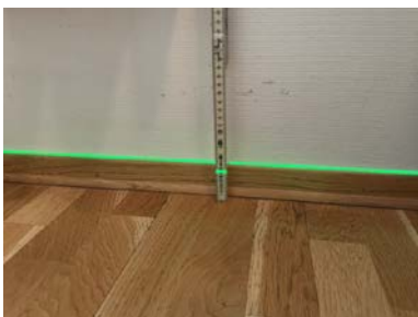
Etasjeskillet er kontrollert med nivelleringslaser.
