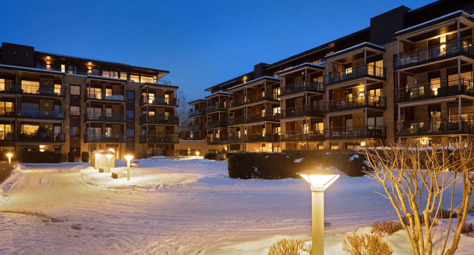
Borettslaget har et pent opparbeide gårdsrom.
