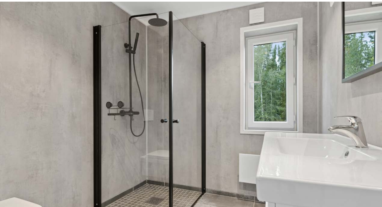
Pent bad fra ca 2020 med flis på gulv og våtromsplater på vegger. Downlights i himling. Panelovn.
