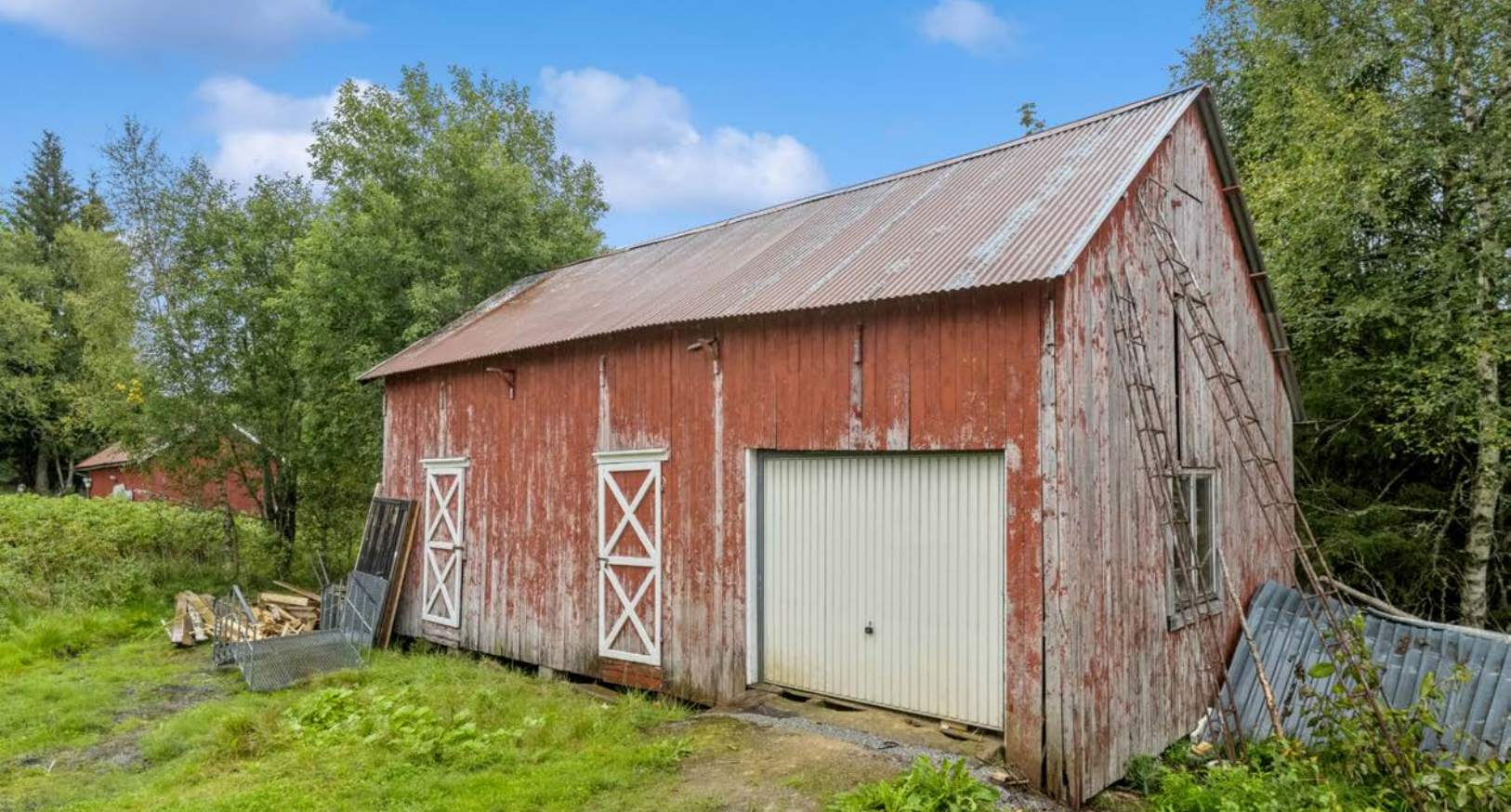
Uthus med del utstyr, med takplater og diverse. Uthuset leveres med innhold og som forevist på visning.
