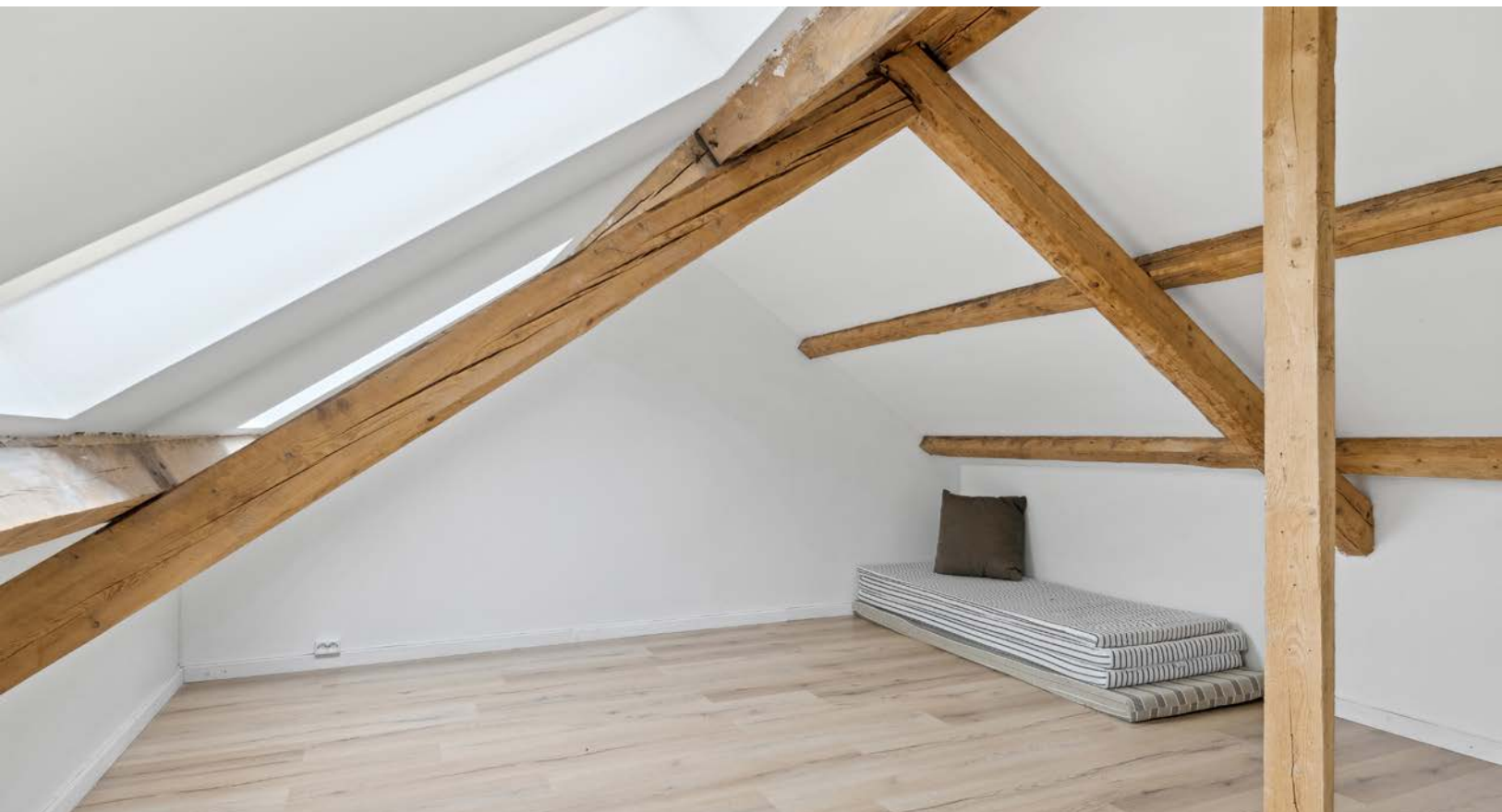
3 nye takvinduer er montert som gir loftet et godt lysinnslipp.
