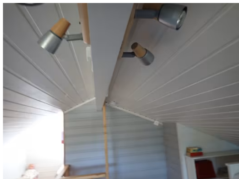
Pipe er innkledd på hems/loft.
