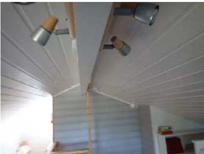
Pipe er innkledd på hems/loft.
