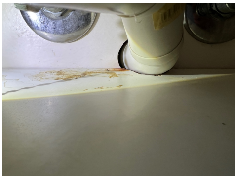
Utettheter rundt avløp.
