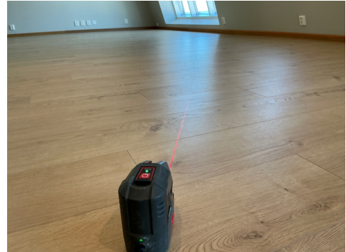
Nivellering stue/kjøkken, ingen registrerte avvik
