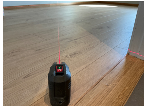
Nivellering soverom, ingen registrerte avvik
