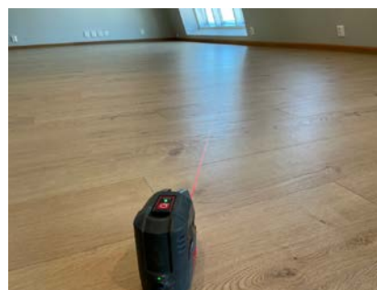
Nivellering stue/kjøkken, ingen registrerte avvik
