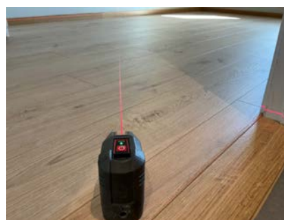
Nivellering soverom, ingen registrerte avvik
