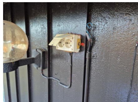
Deksel lukker ikke og ledning ikke festet.
