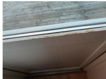
Slitte overflater til terrassedør.
