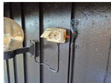
Deksel lukker ikke og ledning ikke festet.
