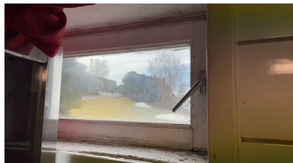
Kjellervindu fra byggeår.
