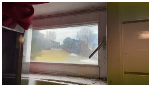
Kjellervindu fra byggeår.
