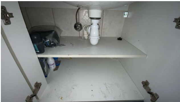
Besiktigelse av røropplegg.
