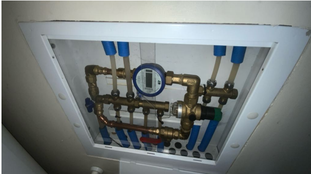
Besiktigelse av røropplegg.
