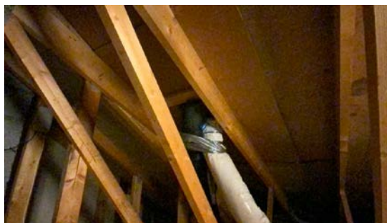
Kontroll rundt rørgjennomføringer.
