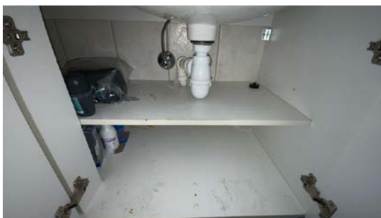
Besiktigelse av røropplegg.
