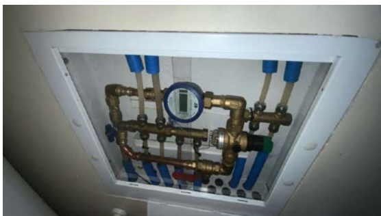
Besiktigelse av røropplegg.
