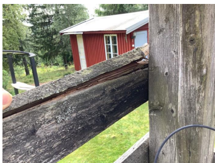
Råteskadet rekkverksbord.
