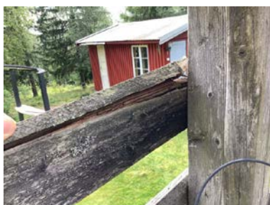
Råteskadet rekkverksbord.
