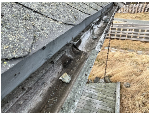
Utettheter i skjøt
